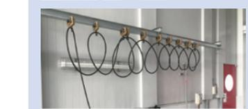
壁面にレール滑車を取り付け、ホースを吊り下げることで、取り回しと水はけを向上。床擦れでの汚れや劣化も防止
