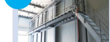
雪降ろしがしやすいよう、壁面にキャットウォークを設置
