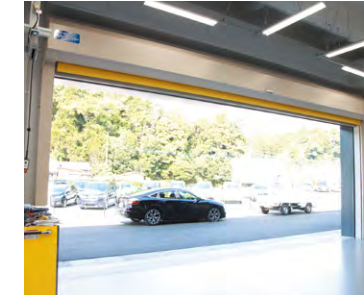
各ストールの出入口にシートシャッターを設置し、空調効率を劇的改善。夏場は空調ベストが不要なほど
