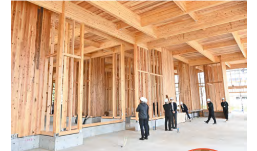
CLTを用いた内部構造がよく分かる、建設中のショールーム・サービス工場。複数の角材をクロスさせて接着した木材を用いることで、重量も鉄筋コンクリートの1/5以下に低減
