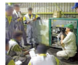
▲温水洗浄機 内部の水漏れや異音がないか確認
