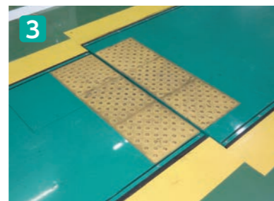
フロアリフトの継ぎ目部分には 安全表示を貼付
