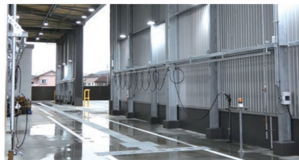
壁を取り払い、中央での切り返し可能な洗車場
