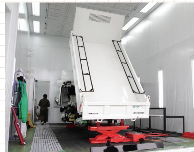
▲塗装ブースは前後に2分割でき、小型トラックなど2台同時作業が可能に
