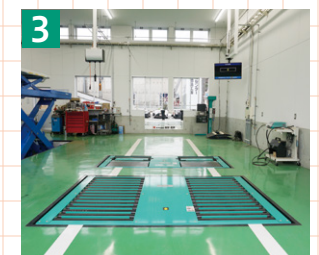
▲検査ラインを一新し、トータル車検ラインシステム“ラインマスター”を導入
