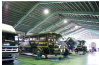
配管のない天井は山形が活かしてスッキリ
