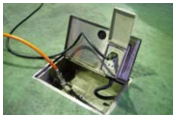
エアと電気は全てエネルギーボックスから供給
