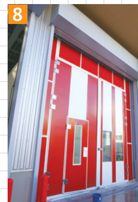
▲熱循環式“キュービック大型車用塗装ブース”を導入
