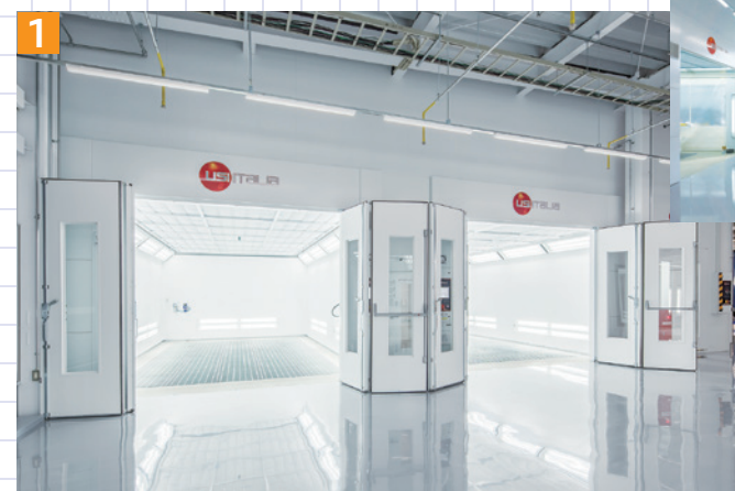
▲塗装ブースは、湿度管理により水性塗料の高品質な作業を実現する「クロノテック」を導入
