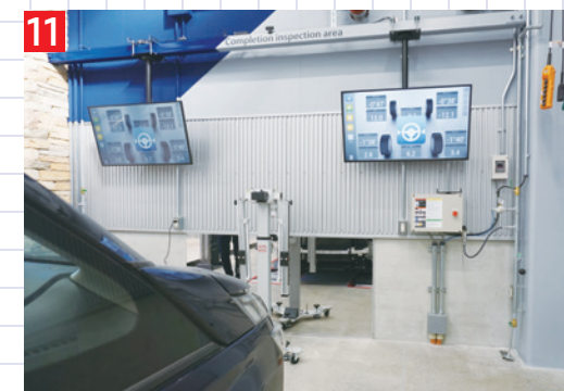
▲診断中は、画面にアイコンが表示され測定手順がわかりやすく表示されます
