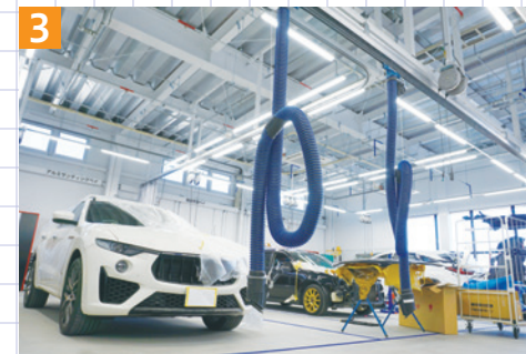
▲サンディングは作業者の健康被害の他、アルミを扱う場合爆発の危険性もあることから高性能の集塵機は必要不可欠
