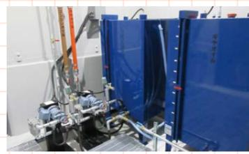
▲従来の油脂庫にはエアポンプ式を採用していたが、電動ポンプの圧送により低騒音・低振動・省電力を実現
