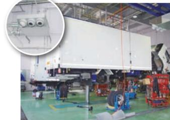
“地下水を利用した空調システム”は箇所から送風が可能で、工場内の空気の淀みや夏の暑さを解消
