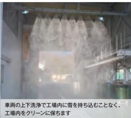
車両の上下洗浄で工場内に雪を持ち込むことなく、工場内をクリーンに保ちます
