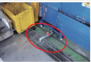
◀ 部品洗浄機の廃液回収用の地下タンクを設置。排出された廃液はそのままタンクにたまり、産廃業者に回収され効率的
