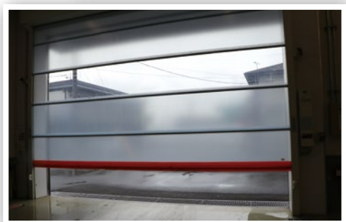
▲暑さと強風対策に高速シャッターを導入。エアコンを完備しているため、作業空間の温度を管理して働きやすい環境づくりに貢献
