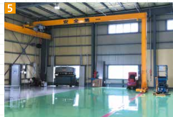
▲無柱構造建築のため、天井走行クレーンは自走式を採用
