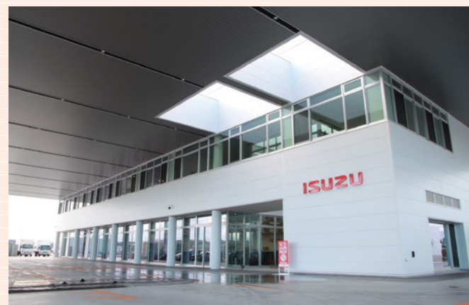
▲雪が積もってもお客様が快適に入出庫できるよう、受付出入口前に巨大キャノピーを設置
