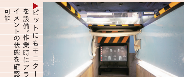
▲既設のピットを流用してピットタイプを選択。後輪にはタイヤがフリーに動くようにスリッププレートを設置
