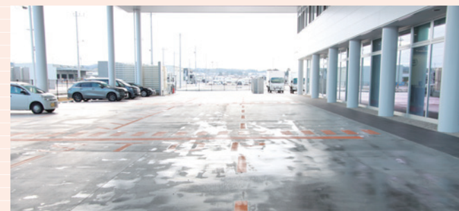
▲サービス工場外周は車両を一方通行としたほか各所に横断歩道を設けて構内事故を防止
