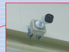
▲スTool毎にカメラを設備。整備のプロセスをエビデンスとして記録
