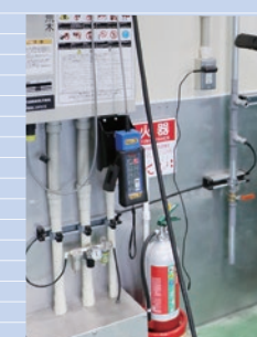
▲工場壁面に腰の高さまでステッスを貼ることで付着した汚れを落とす工法
