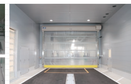
▲エアコンを完備し各スツールにダクトを通したほか、出入口に電動シャッターを設けて空調効率をアップ。屋外への騒音低減にも効果を発揮
