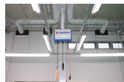
▲エアコンを完備し各スツールにダクトを通したほか、出入口に電動シャッターを設けて空調効率をアップ。屋外への騒音低減にも効果を発揮
