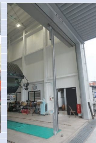
▲台風対策としてシャッターの中心に支柱を建てるのは沖縄では標準
