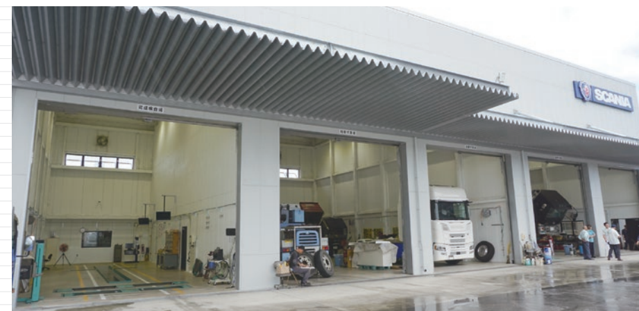
▲検査ラインを含めて全6 ストールを配備。特殊車両の入庫を想定し、高さとお行をしっかりと確保
