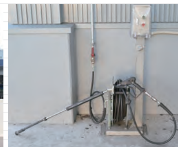
▲6基の“高圧温水洗浄機”を配置したスチーム洗車場。“車両自走式下部洗浄装置”も併設
