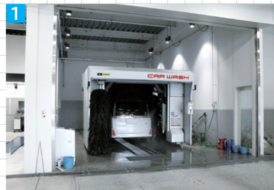
▲「省スペース型門型洗車機ゼクス」。6本目のブラシ、フロントサイドブラシによりレール長を短縮。節水、低床、低騒音の下部洗 AUW-214も設備。水切り用グレーチングも併設することで整備ストールに水を持ち越さないように
