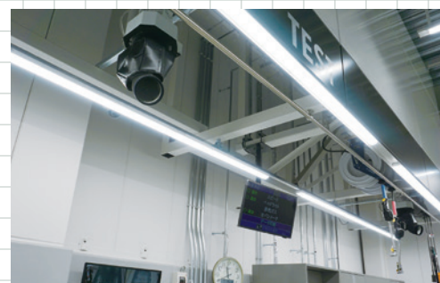
▲垂れ壁により、リール本体を隠し、工場内の美観を向上
