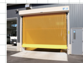
▲クイック整備ストールと完成検査場の出入口はスピードシャッターを設置し、暖房効率をアップ
