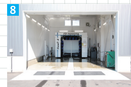
▲洗車ストールは床暖房を完備
