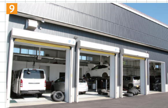
▲クイック整備ストールと完成検査場の出入口はスピードシャッターを設置し、暖房効率をアップ
