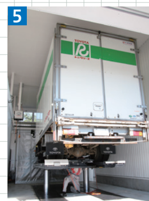
▲ドライブオンタイプの“フォーマルリフト”。アンダーコート塗布時の飛散防止で自動式の間仕切りロールカーテンを天井に設置
