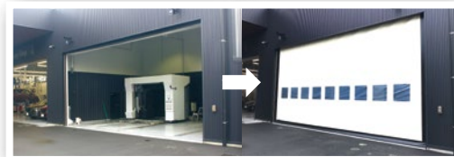
▲洗車ストールは住宅地の多い周辺環境を考慮し、防音効果のあるエアシャッターを設置。水しぶき対策にも貢献
