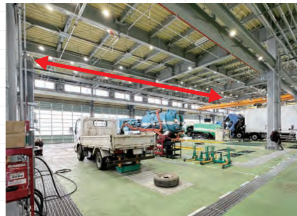
吊り下げリール架台を取り払ったことで、天井走行クレーンの可動範囲を拡大
