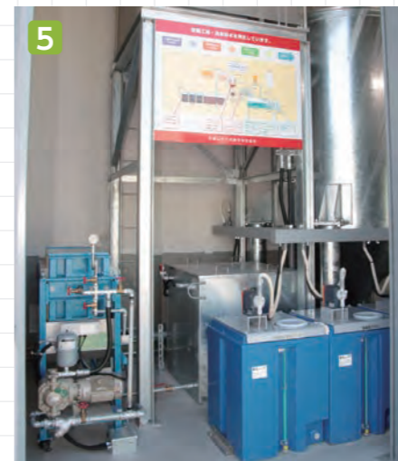
バクテリアで汚れを分解する排水処理装置を導入し、整備工場と洗車場から出る排水を再生。水質基準をクリア
