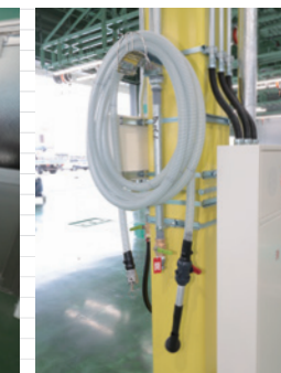
▲工場内のダスト・廃油を「MVシステム」で集中吸引。省力化・美観に貢献
