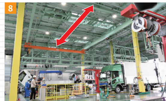
▲「自立式リール架台」を導入し天井クレーンの走行範囲を拡大、美観向上にも
