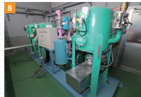
▲工場内のダスト・廃油を「MVシステム」で集中吸引。省力化・美観に貢献
